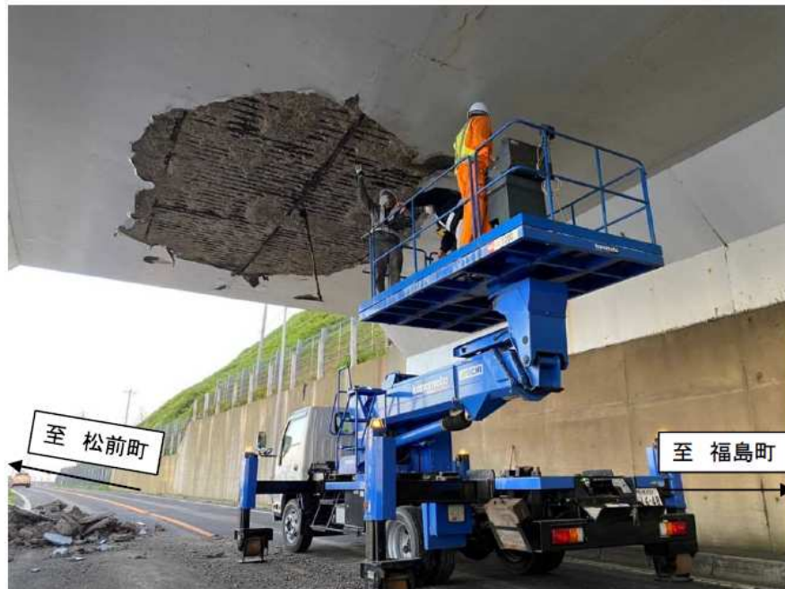
<有識者による点検状況>
