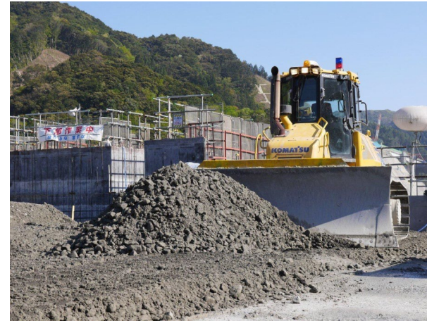
自動ブルドーザ: まき出し作業の自動化
