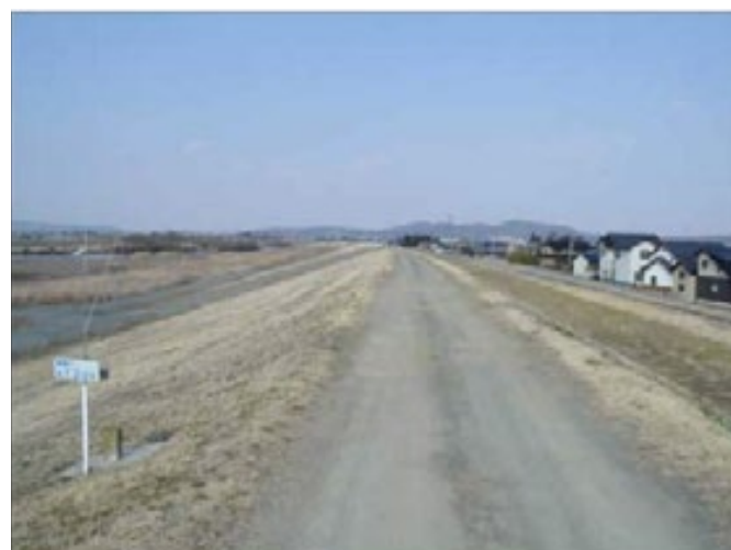
地盤改良箇所
