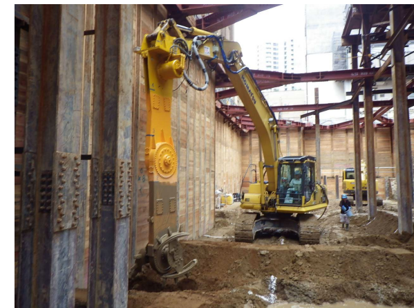
(c) 狭隘地施工
