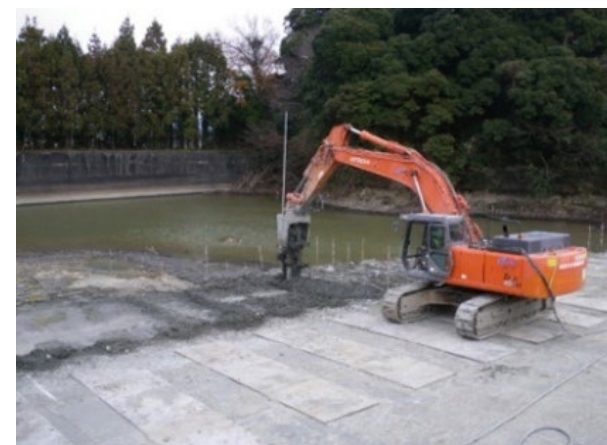
(e) 足場を確保しながらの泥土改良
