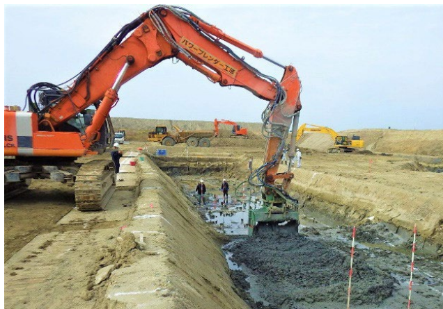
(a) 段差施工
