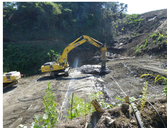
(b) 傾斜地施工 18)
