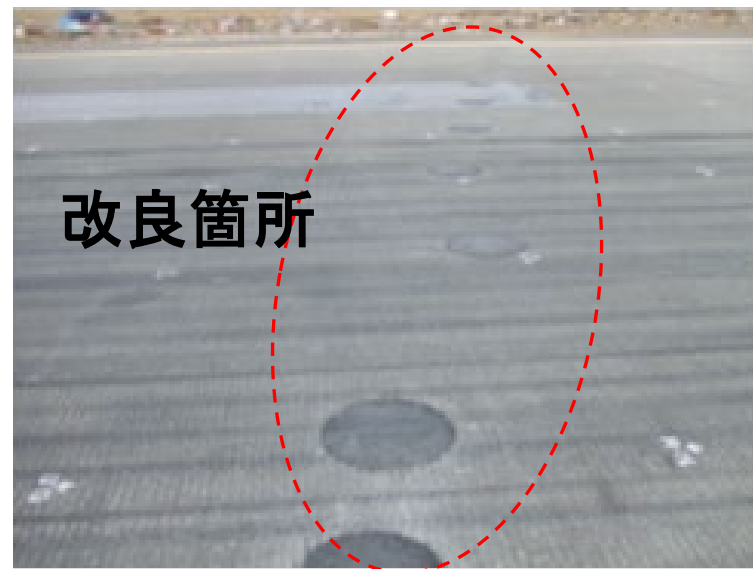
地盤改良箇所
