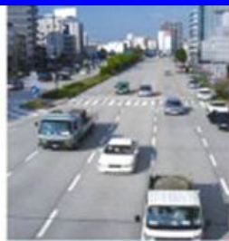
コンクリート舗装
