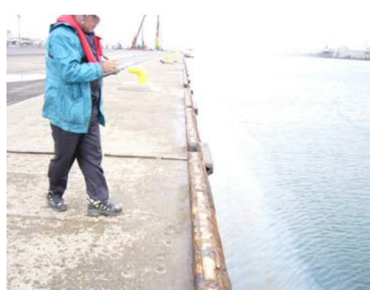
雷神埠頭地盤改良箇所
