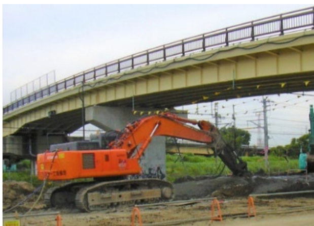
(d) 上空制限下での施工
