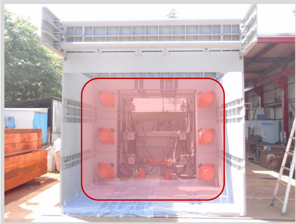
側部・底部が囲われた 空間に函体を敷設
