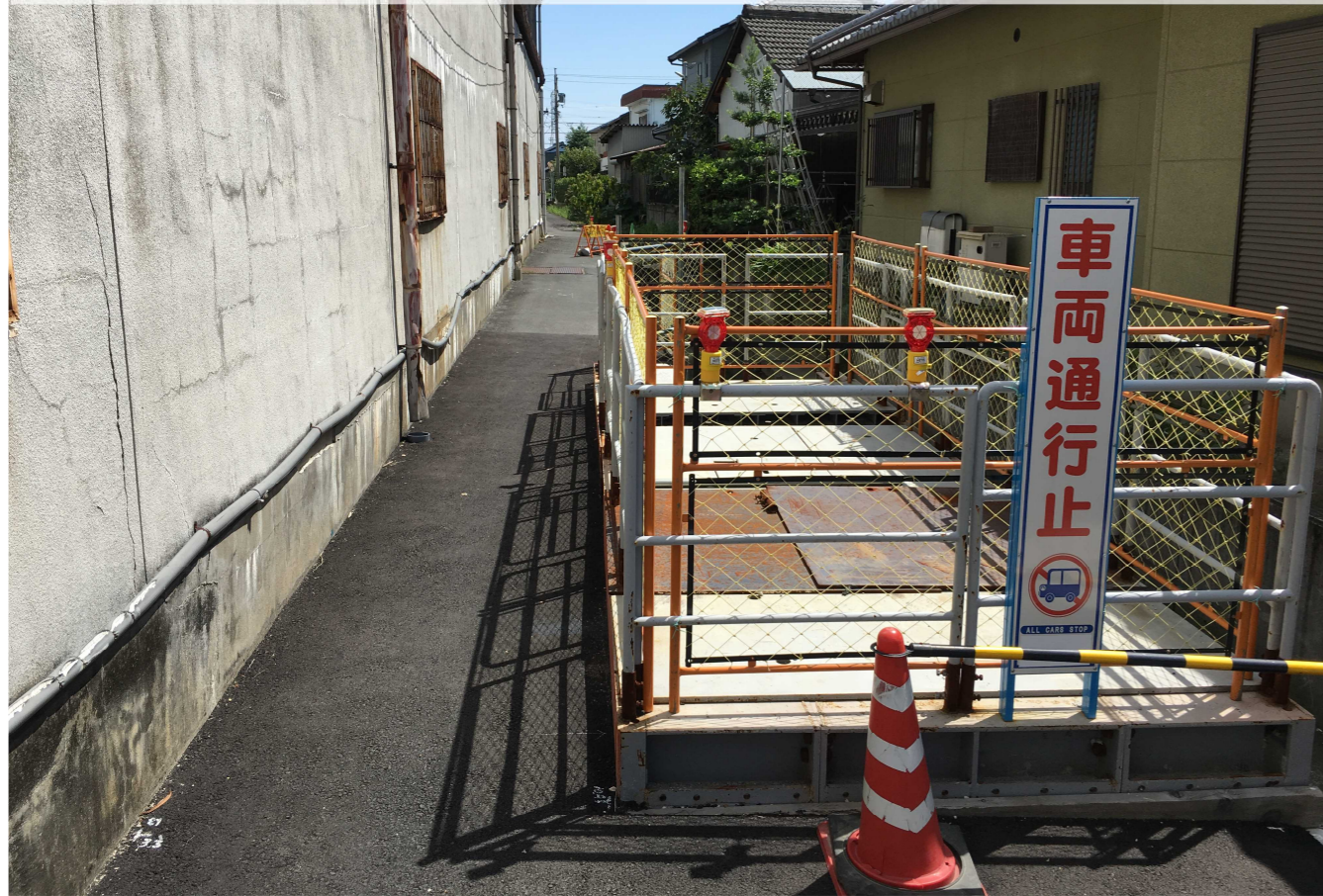
残置状況（シールド機後方より）
