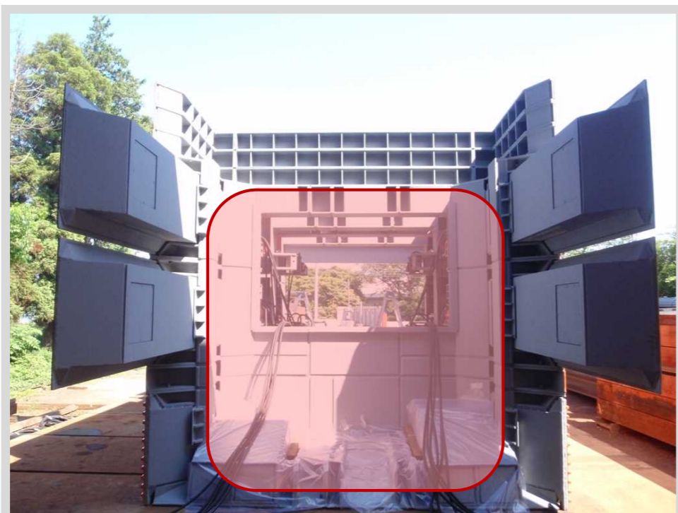
防護された切羽内部を掘削
