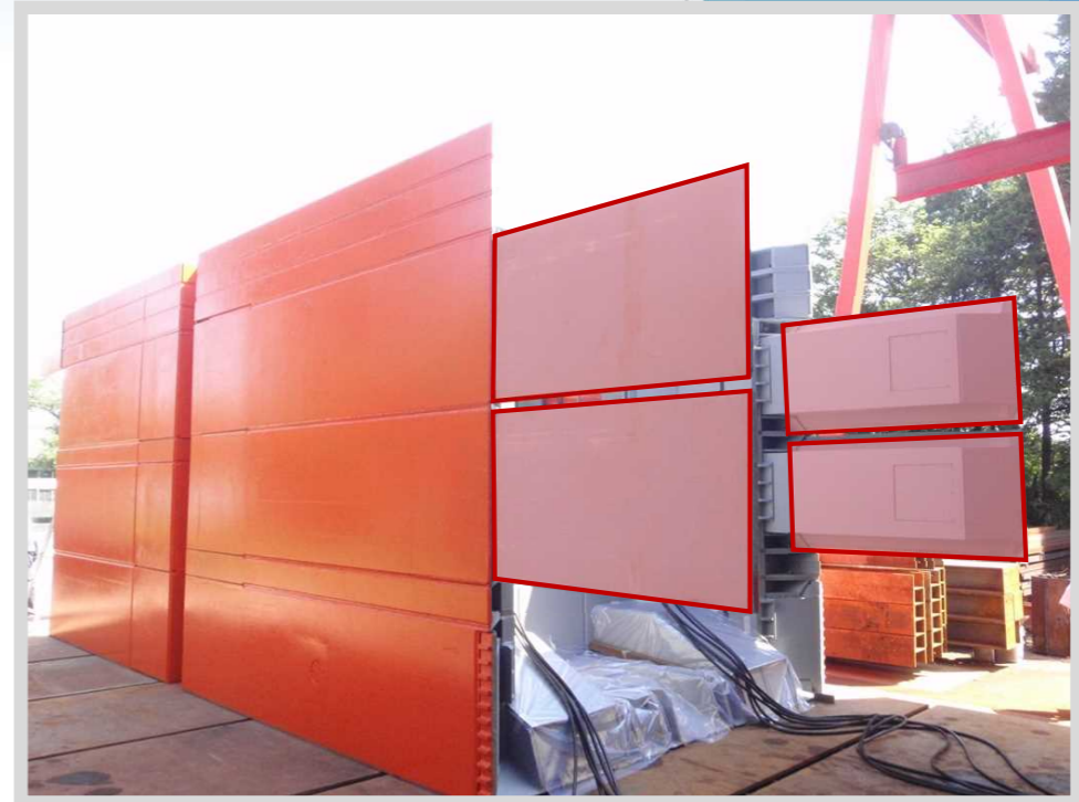
スライド式土留で 地山崩壊を防止
