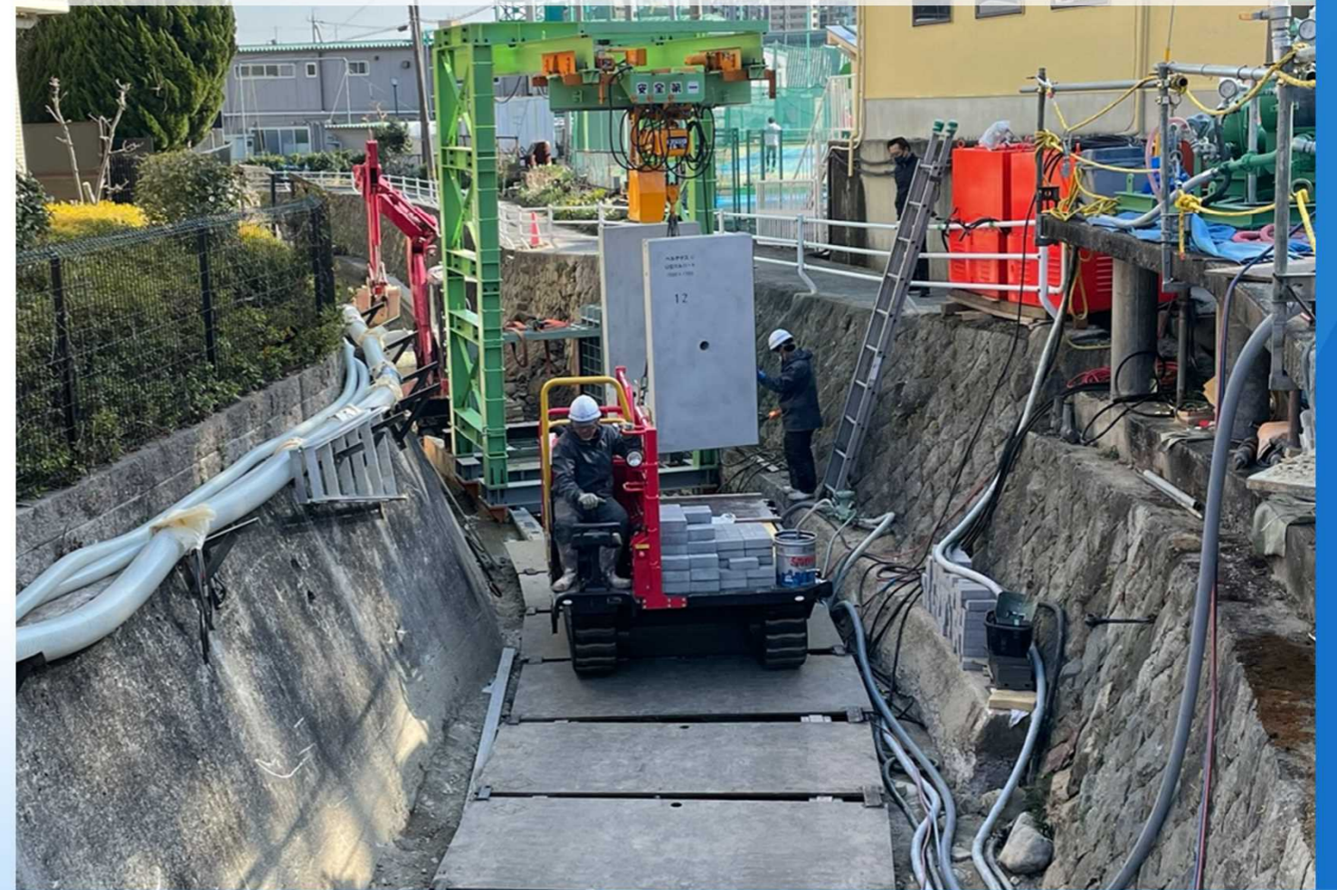
函体据付状況
