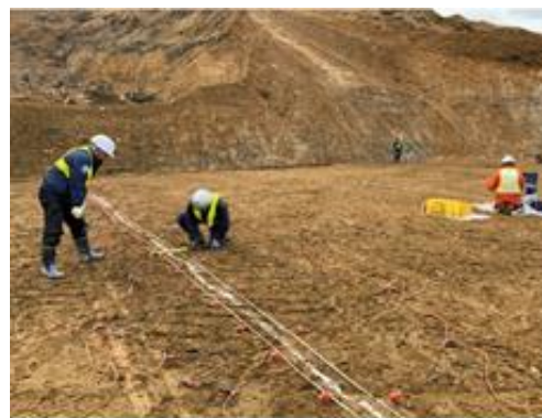
2次元表面波探査作業状況
